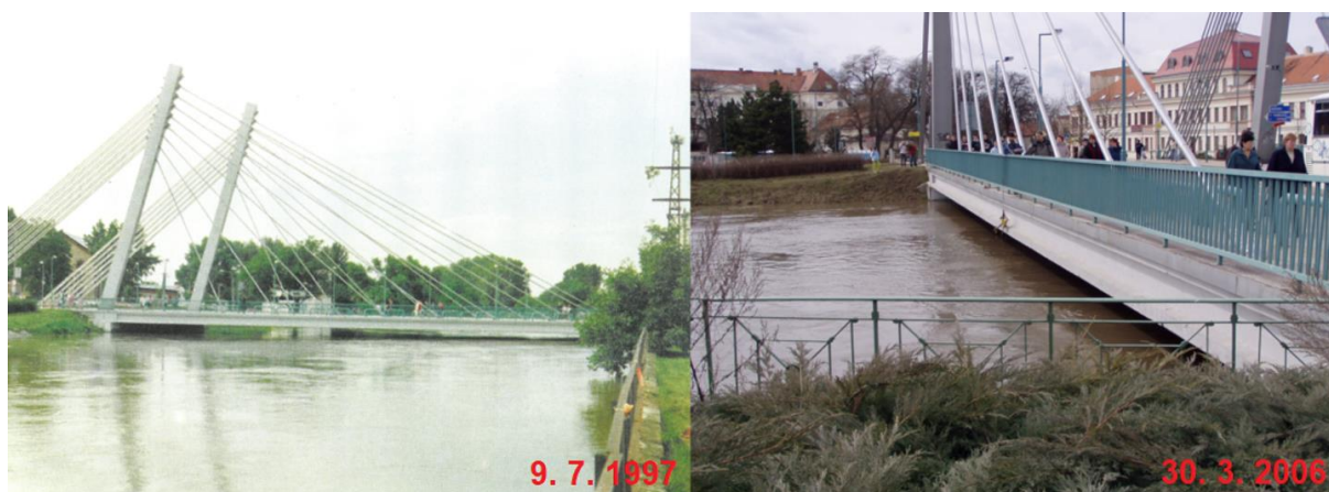
Obrázek 10: Zvýšená hladina Svatky v Židlochovicích za povodní v roce 1997 a 2006. Foto: archiv ČHMÚ Brno.
