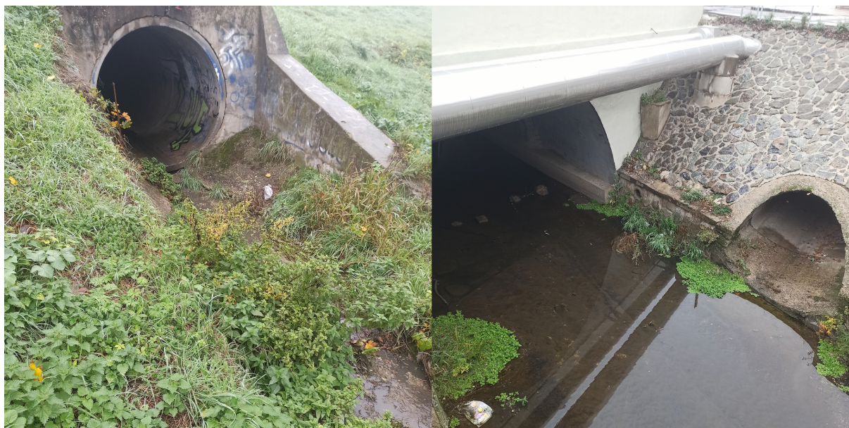
Obrázok 3. Odľahčovacia komora č. 1 (ľavá strana obrázka) a č. 2 (pravá strana obrázka)
