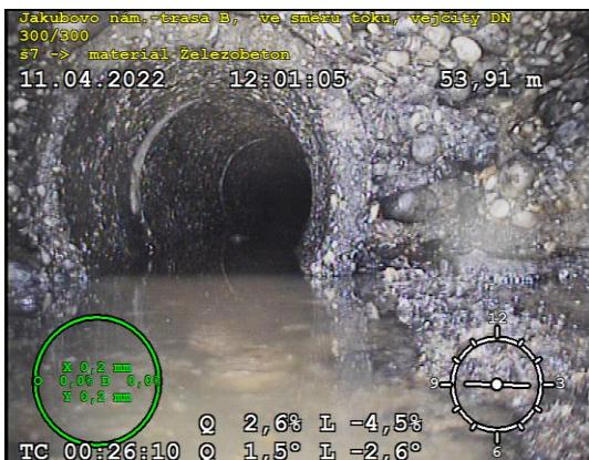
Obrázok 1. Zatopenie kanalizačného potrubia
