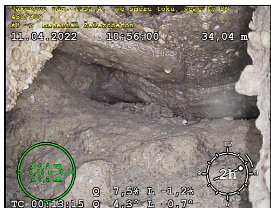
Obrázok 2. Prevalenie kanalizačného potrubia
