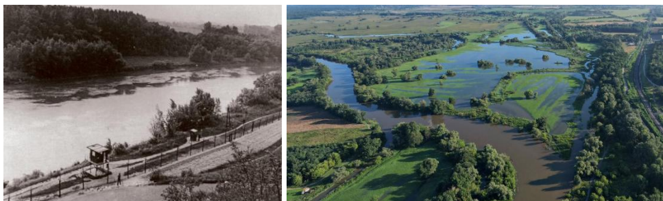
Obrázek 3: Řeka Morava – vlevo historický stav – regulované koryto (Děvín); vpravo řeka v rozlivu – středně vysoký průtok
