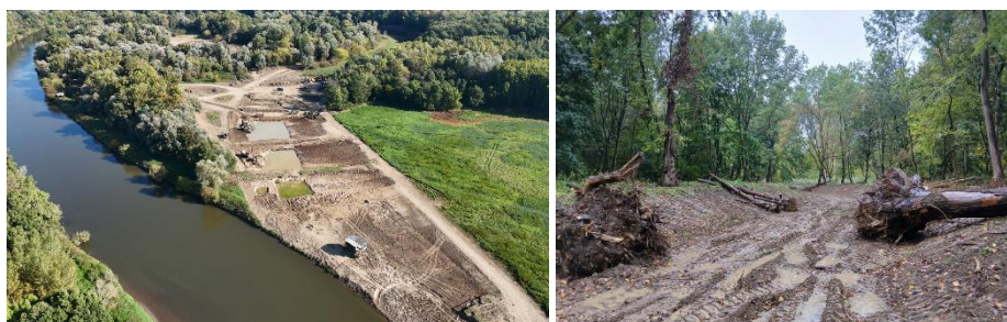
Obrázek 2: Ukázky stavby revitalizace Moravy, vlevo – vyhloubení koryta integrovaného meandru výtok; vpravo – vyhloubený úsek propojení relikvů doplněný o mrtvé dřevo
