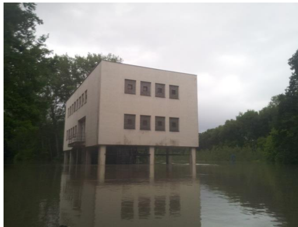
Obr. 13. Úroveň vody pri 2. st. PA na ostrov Sihot'.
