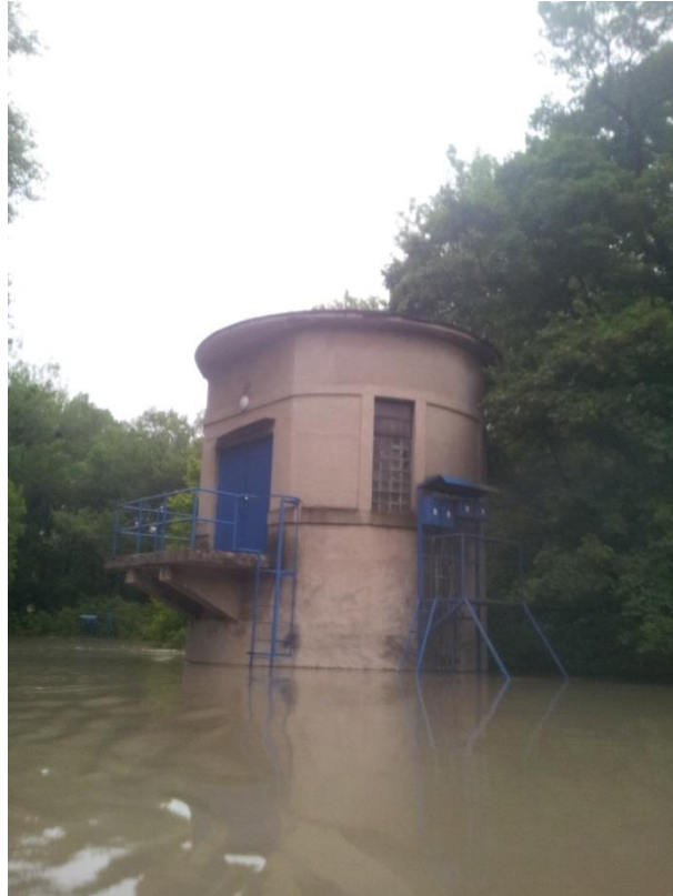
Obr. 15. Úroveň vody po prekročení 3 st. PA na ostrov Sihot'.
