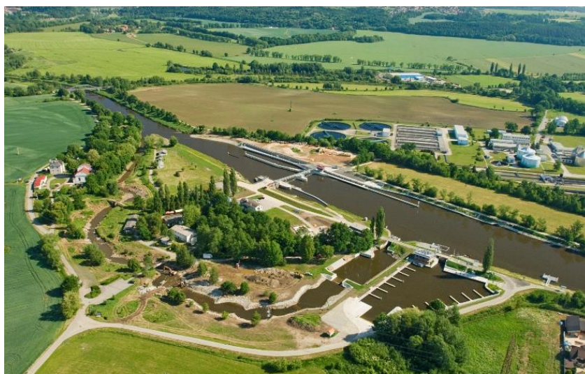
Obr. 2 Letecký pohled na modernizovaný areál v Českém Vrbném [1]
