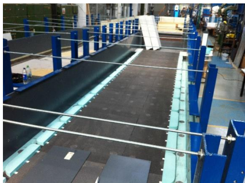
Obr. 5 Plavební komora před instalací stěn PK
