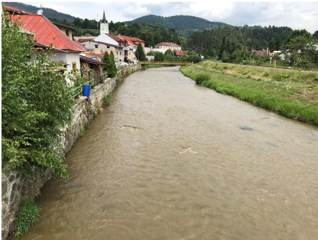
Obr. 2 Pohľad smerom proti prúdu na existujúci oporný múr na pravom brehu a železničný násyp na ľavom brehu Hrona
